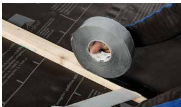
TESCON NAIDEX mono als nageldichting tussen de tengellatten...
