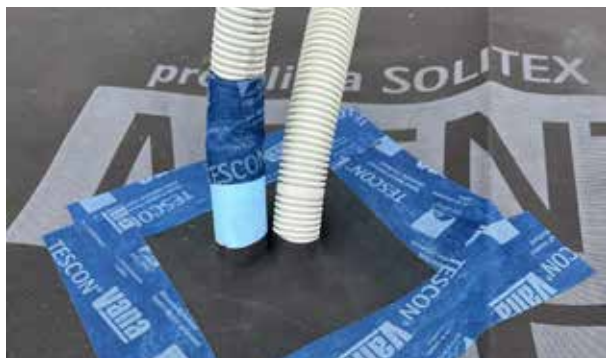
Regendichte aansluiting van mantelbuizen met ROFLEX-multi-manchet voor meerdere mantelbuizen...
